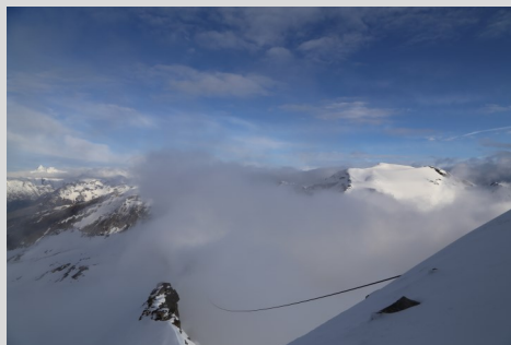
Abb.2: Energiekabel des Sonnblick Observatoriums Fig.2: power cable of the Sonnblick Observatory Quelle/Source: E.Ludewig@ZAMG-SBO
