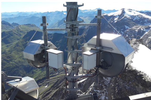
HAMNET 5GHz Datentransport über 80km HAMNET 5GHz data transmission over 80km Quelle/Source: Norbert Gröger
