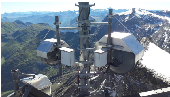
HAMNET 5Ghz Datentransport über 80km HAMNET 5Ghz data transmission over 80km Quelle/Source: Norbert Gröger
