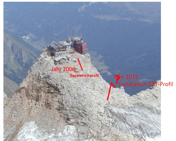
Abbildung 71: Lage des ERT-Profiles im Jahr 2006 sowie der geplanten Neuinstallation im Jahr 2015 (Foto: M. Staudinger; bearbeitet von R. Supper, A. Römer und S. Reisenhofer).
