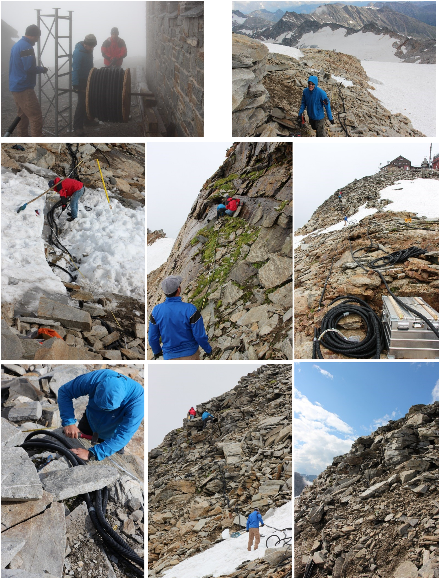
Abbildung 74: Installation des Geoelektrikprofils am 14. und 15. Juli 2015 (Foto: S. Reisenhofer).
