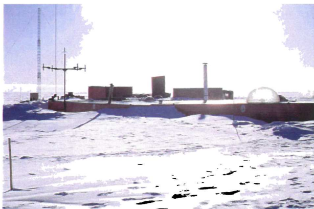
Abb. 1: Die Plateau Station war ein Jahr nach ihrer Errichtung schon teilweise mit Schnee zugeweht.
