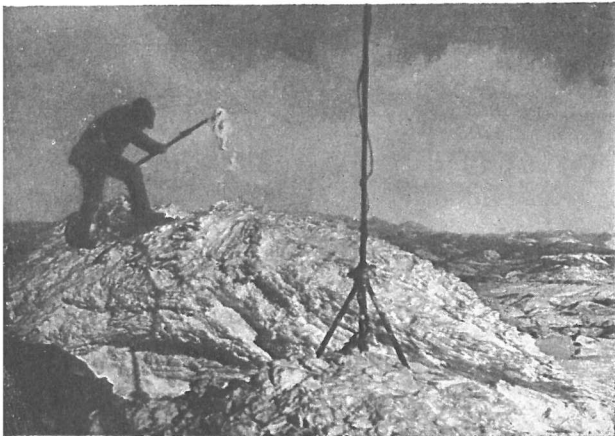
Befreiung des Rauchfangs vom Eis. (Ansatz etwa 2 m )
