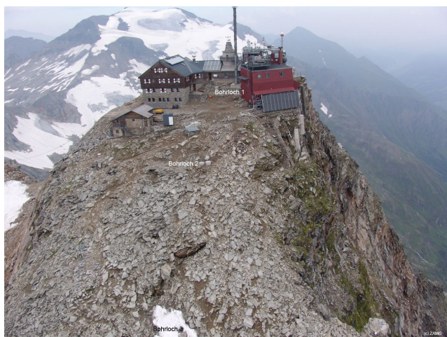
Lage der Bohrlöcher an der Südseite des Sonnblickgipfels Location of the boreholes at the summit of Hoher Sonnblick Quelle/Source: ZAMG/Riedl
