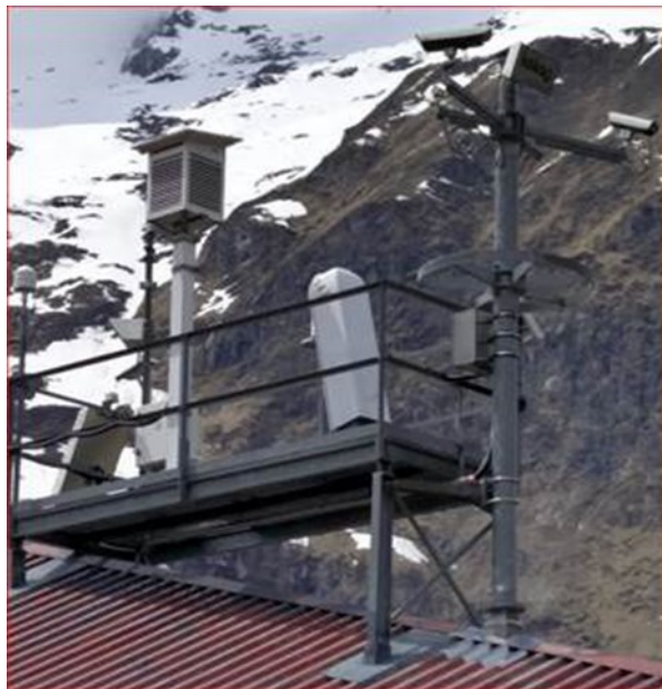
Ceilometer (schräges weißes Gehäuse) am Dach der Talstation der Materialseilbahn zwischen Kolm-Saigurn und Sonnblick-Observatorium Ceilometer (inclined white box) on the roof of the valley station of the ropeway for material transport between Kolm-Saigurn and Sonnblick Observatory Quelle/Source: Leonhard Hettegger, ZAMG
