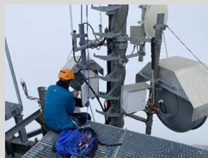
HAMNET 5Ghz Datentransport über 80km HAMNET 5Ghz data transmission over 80km Quelle/Source: Norbert Gröger
