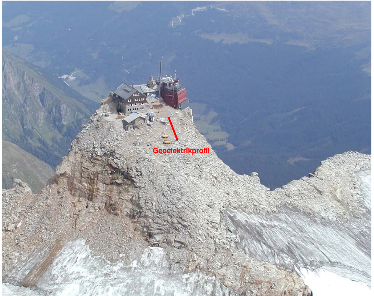
Abb. 1A: Lage des geoelektrischen Profils am Hohen Sonnblick (Foto: Michael Staudinger)
