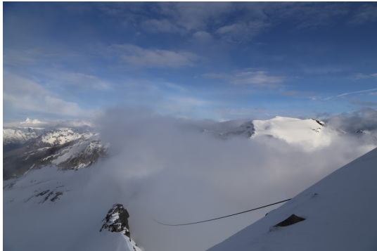
Abb.1: Energiekabel des Sonnblick Observatoriums
