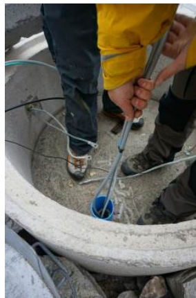
Steinschlag-Messungen in den Hohen Tauern: Installation des Messgeräts im 20 Meter tiefen Bohrloch beim Sonnblick-Observatorium. Quelle ZAMG/Binder.
