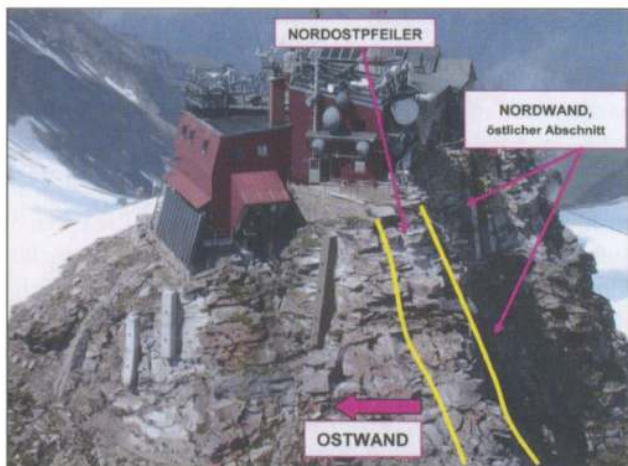
Abb.1: Geologisch-felsmechanische Aufnahmeareale im Nahbereich der Bergstation der Materialseilbahn
