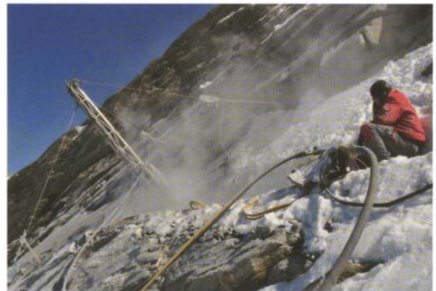
Abb. 1: Instrumentierungsarbeiten, abteufen der bis zu 30 m tiefen Bohrlöcher.
