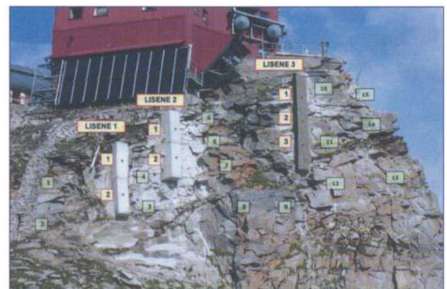
Abb.2: Ansicht der Felsicherungen (obere Ostwand: 15 SN-Anker, 3 verankerte Stahlbetonlisenen sowie Spritzbetonplombierungen und -unterfangungen)
