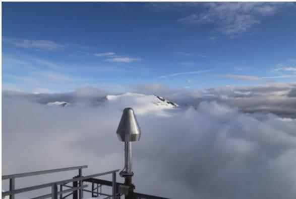
Abb.1: Zentrale Ansaugung für Spurengasmessungen
