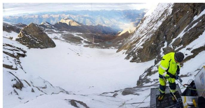
Abbildung 2: Instrumentierungsarbeiten an einem 30 m tiefen Bohrloch unterhalb der Kitzsteinhorn-Gipfelstation durch Firma GEODATA (Foto: M. Keuschnig)
