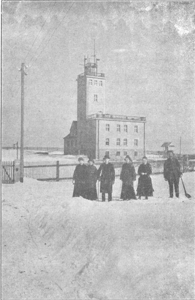
Fig. 1. Die Wetterwarte Wahnsdorf bei Dresden.
