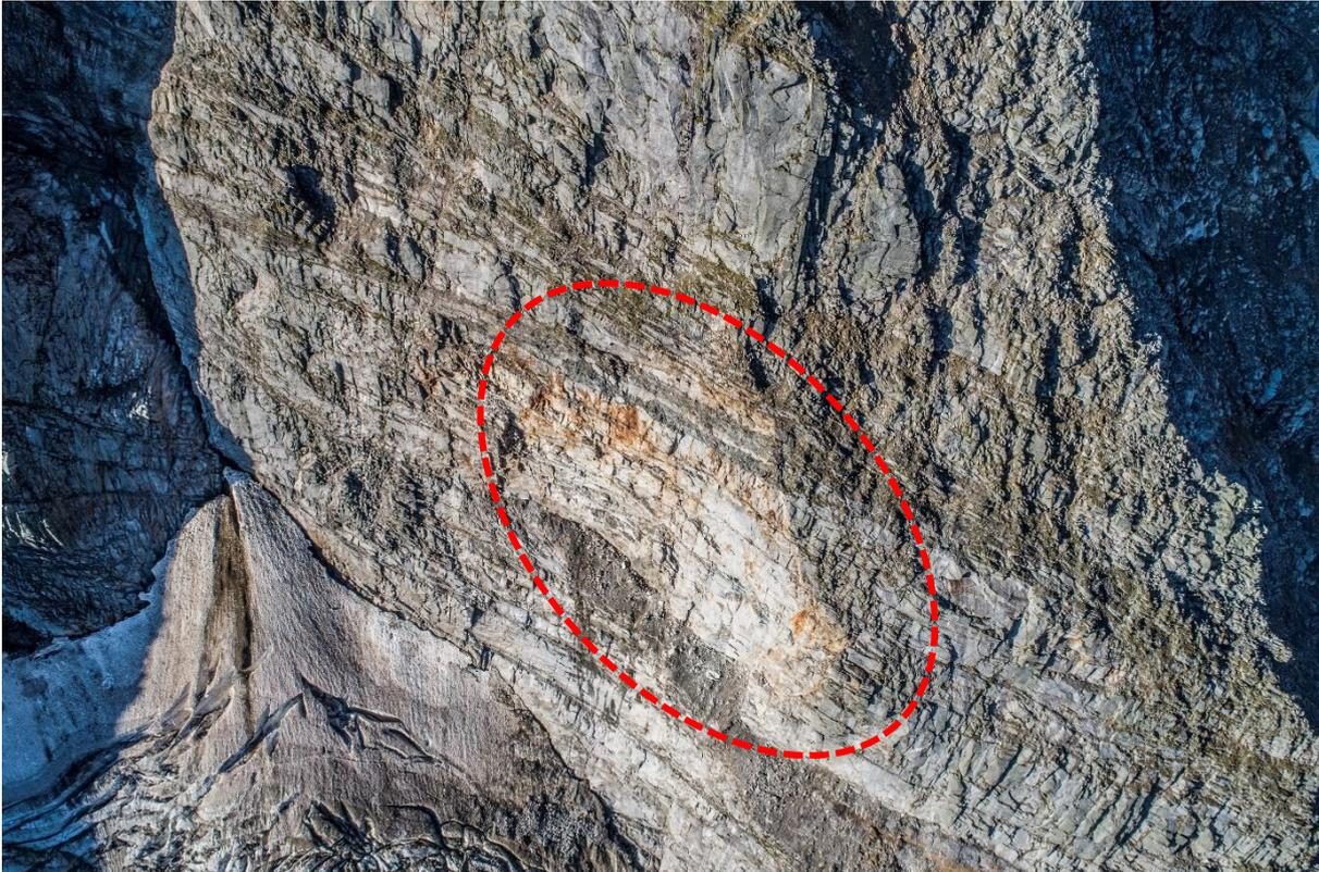
**Abbildung 11:** Die Ablösebereiche der Felsstürze vom 30.08.2020 und 05.10.2021 (rot markiert) heben sich auf Grund ihrer Helligkeit deutlich von der umgebenden Felswand ab (Foto: UAV-Befliegung vom 25.08.2022).
